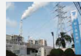
九州電力(株) 発電所内事務所(複数)
